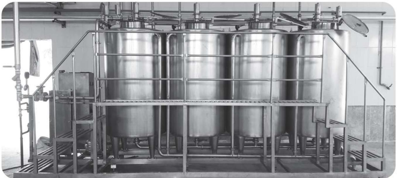
سیستم شستشو در محل یا C.I.P یکی از سیستم های شستشو می باشد که بسته به خطوط تولید مواد غذایی عمده ای مایعات، مورد استفاده قرار می گیرد و با ۳ الی ۴ مرحله شستشو طراحی و در کارخانجات تولید مواد غذایی، دارویی و شیمیایی نصب می گردد و به صورت دستی نیمه اتوماتیک و تمام اتوماتیک (PLC) ساخته می شوند.
